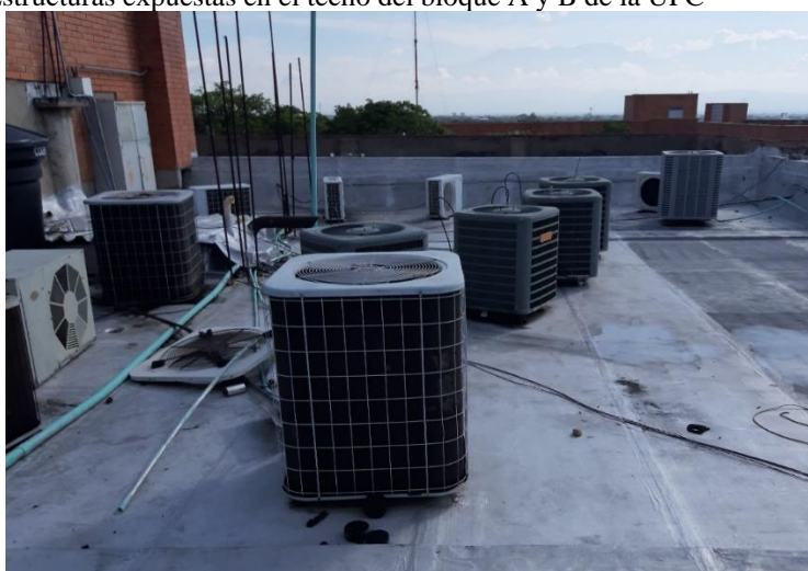
Figura 13: Estructuras expuestas en el techo del bloque A y B de la UPC
