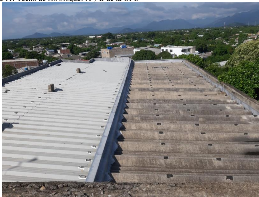
Figura 11: Techo de los bloques A y B de la UPC
