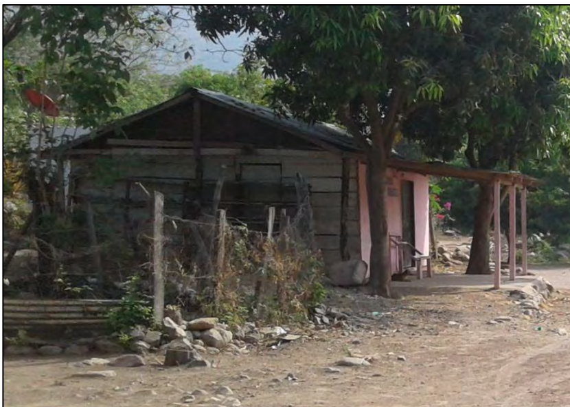
Foto 2: vivienda en madera corregimiento Minas de Iracal
