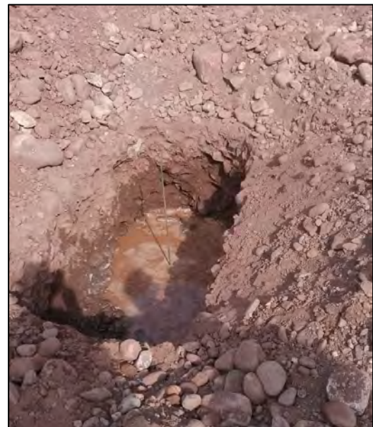
Foto 9: Prueba de Percolación (medición)
