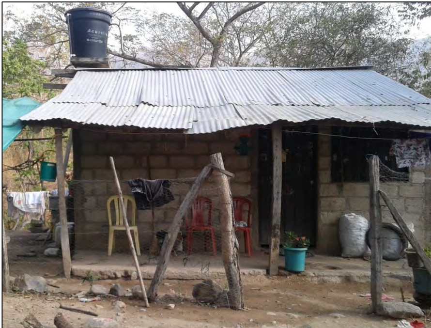
Foto 1: vivienda en mampostería corregimiento Minas de Iracal
