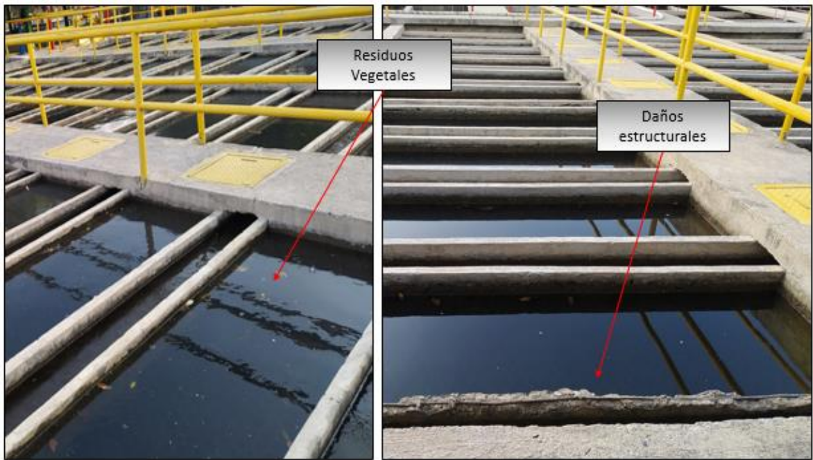
Figura 8. Condiciones de las unidades de sedimentación
