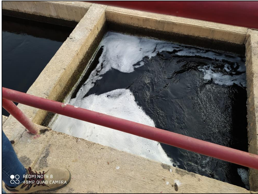
Fotografía 4. Formación de espumas en cámaras finales de floculación
