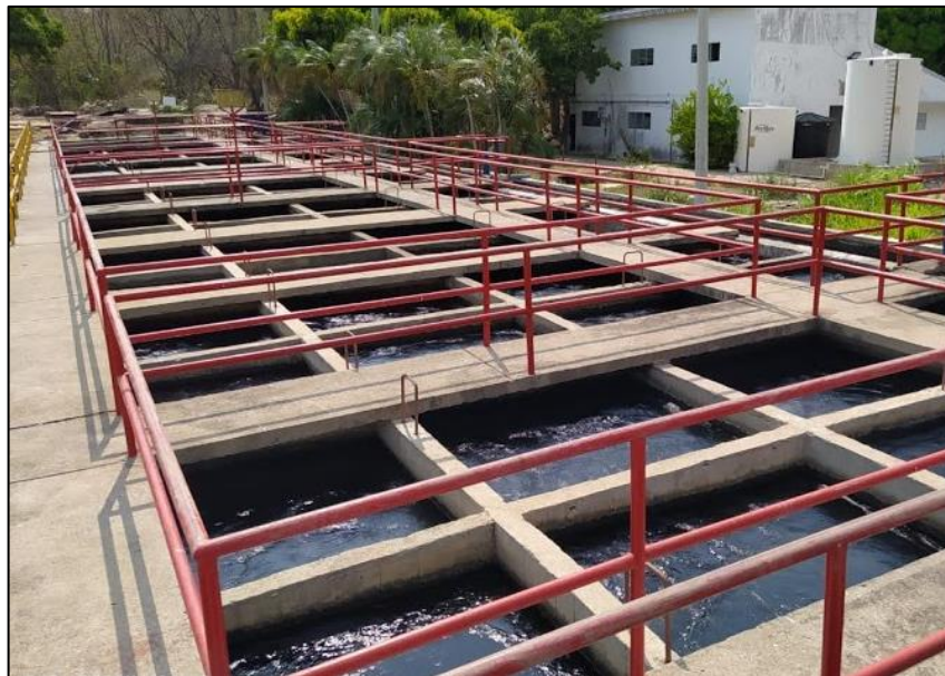
Fotografía 3. Módulos o Unidades de Floculación
