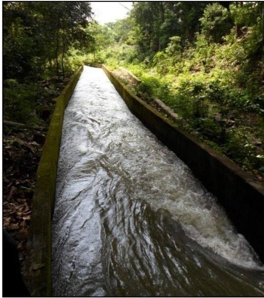
Fotografía 1. Canal de aducción
