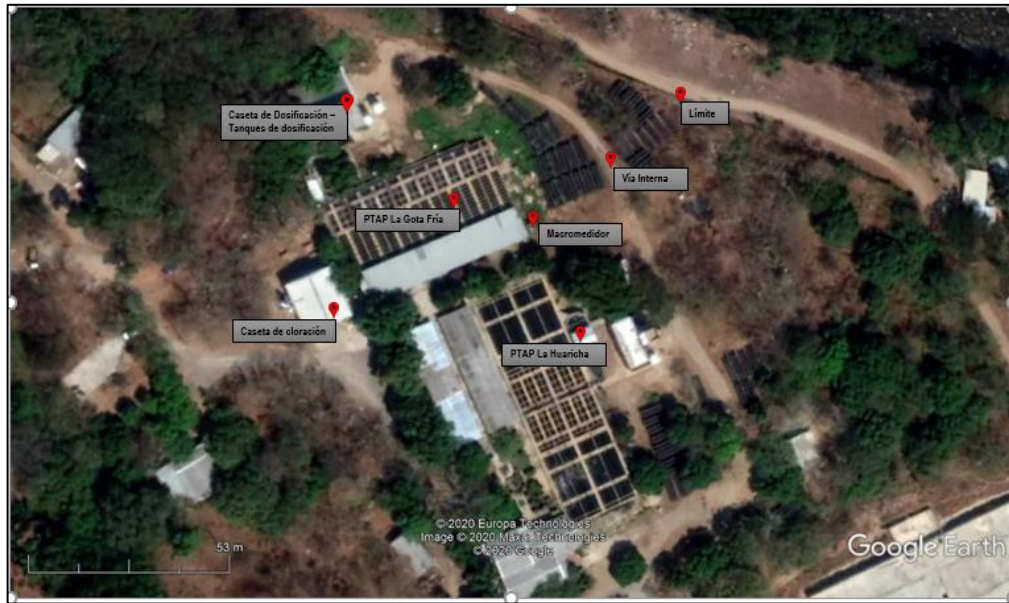
Ilustración 7. Infraestructura Existente del sistema de tratamiento de agua potable de la ciudad de Valledupar perteneciente a la empresa EMDUPAR S.A. E.S.P.
