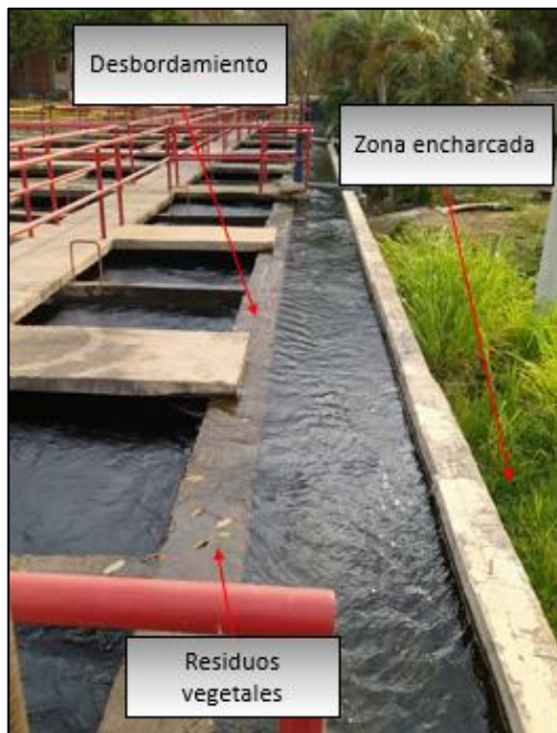
Figura 7. Condiciones del canal de admisión a floclador
