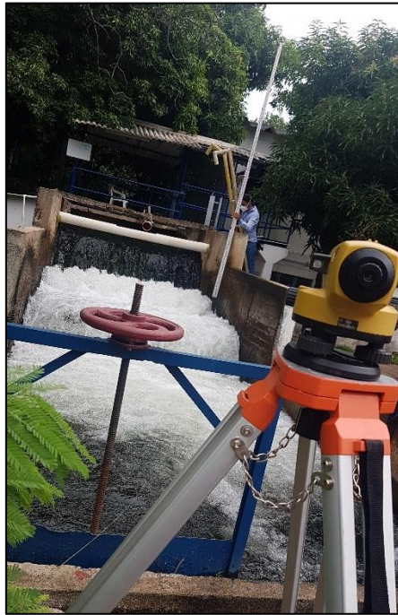
Fotografía 15. Nivelación Topográfica (unidad de Mezcla Rápida)
