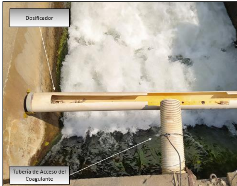
Figura 5. Dosificador de Coagulante
