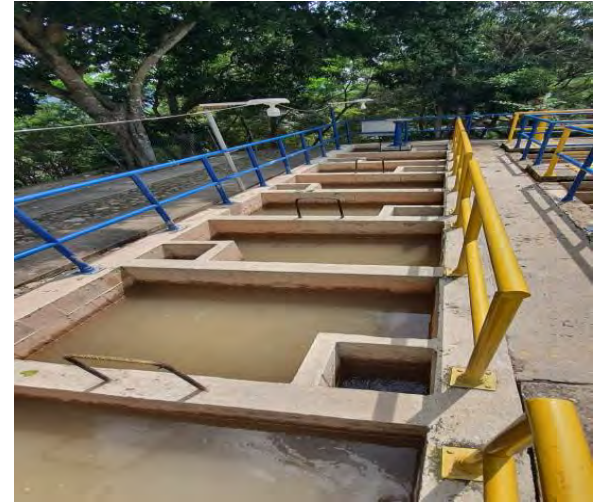
imagen10. Floculadores tipo Cox Q=40 lps
