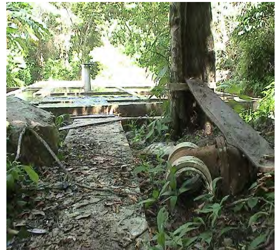
Foto No. 12: Zona de entrada Desarenador
