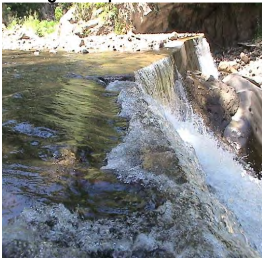
Foto No. 03: Cauce quebrada Arroyo Hondo
