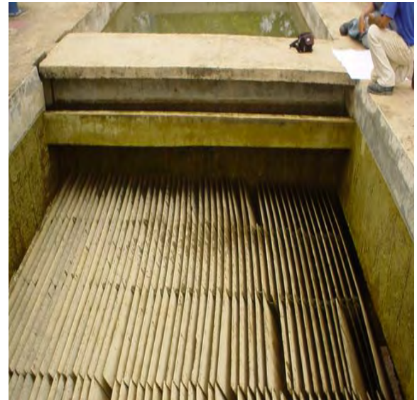
imagen12. Estado del módulo de alta tasa
