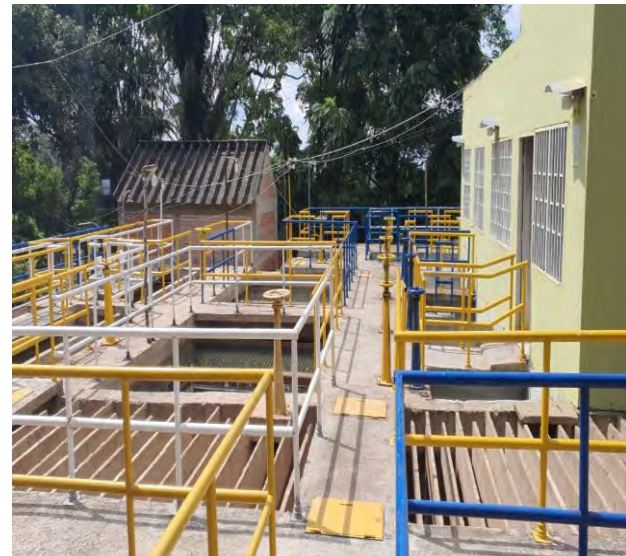
imagen18. Vista general del edificio PTAP
