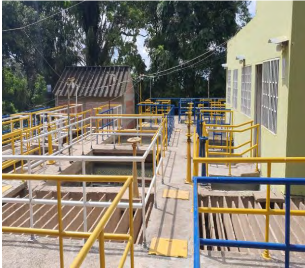
imagen13. Vista general planta de tratamiento
