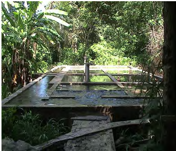
Foto No. 11: Vista general desarenador existente
