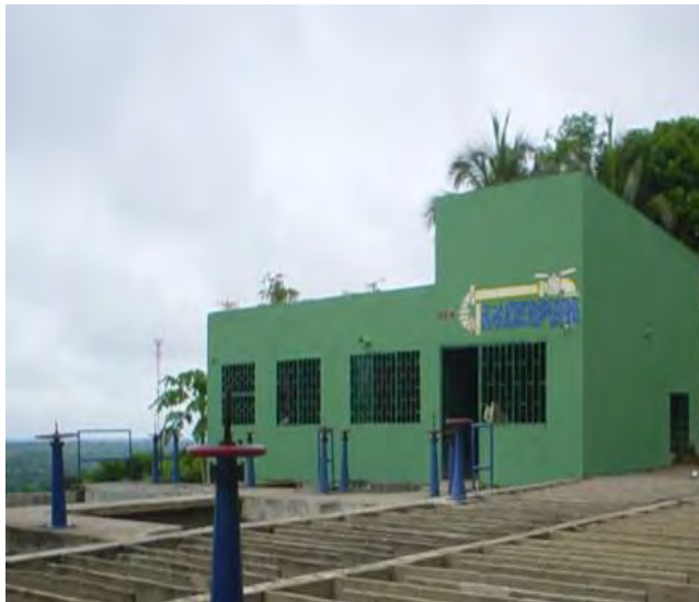
imagen17. Vista general del edificio PTAP
