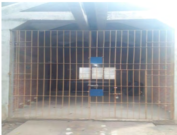
imagen15. Caseta dosificación de Cloro
