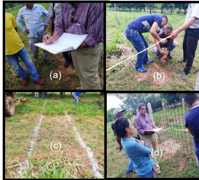
Imagen 31. Trazado para la zanja Fuente: autores
