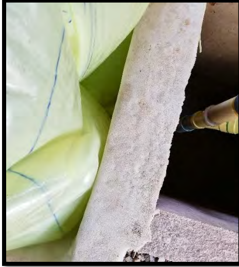
Imagen 42. Recubrimiento de la zanja en material esponjoso Fuente: Autores.
