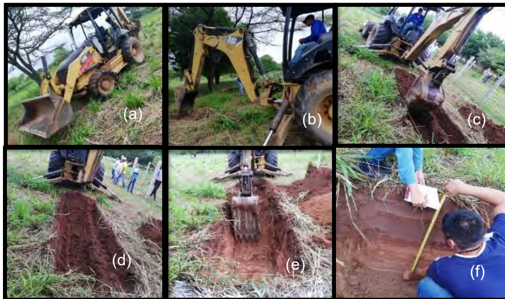
Imagen 32. Excavación de la zanja Fuente: Autores
