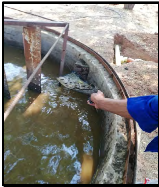
Imagen 55. Remoción de material suspendido en el estercolero Fuente: Autores
