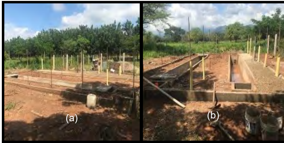
Imagen 33. Recubrimiento de la zanja en concreto Fuente: Autores
