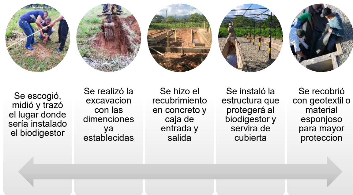
Gráfico 4. Procedimiento de la elaboración de la zanja para el biodigestor Fuente: Autores
