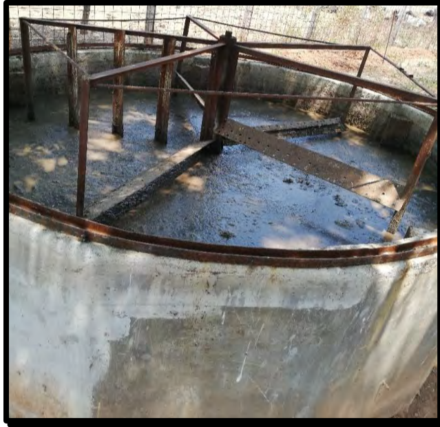
Imagen 52. Tanque estercolero Fuente: Autores
