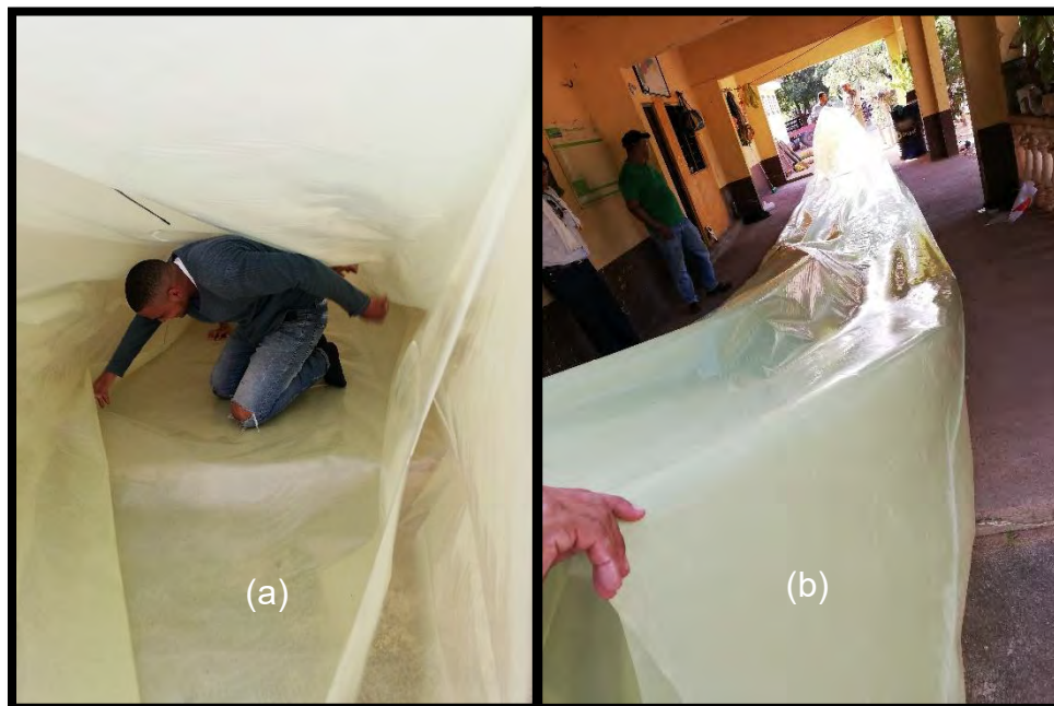
Imagen 37. Introducción de un plástico dentro del otro.
