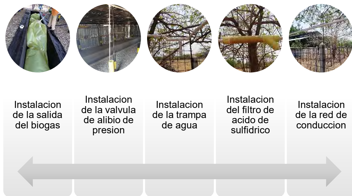
Gráfico 7. Instalación de las Redes de conducción del biogás.
