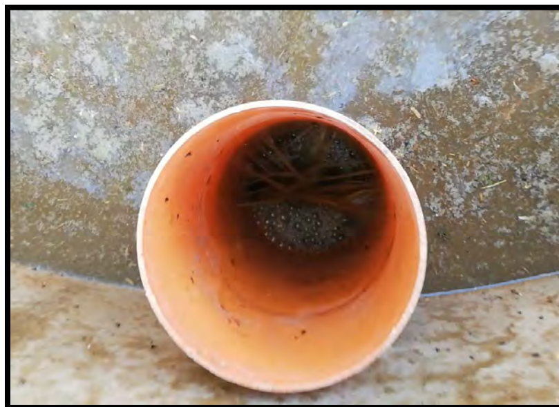
Imagen 51. Filtros en el tanque estercolero y en el tanque de distribución.
