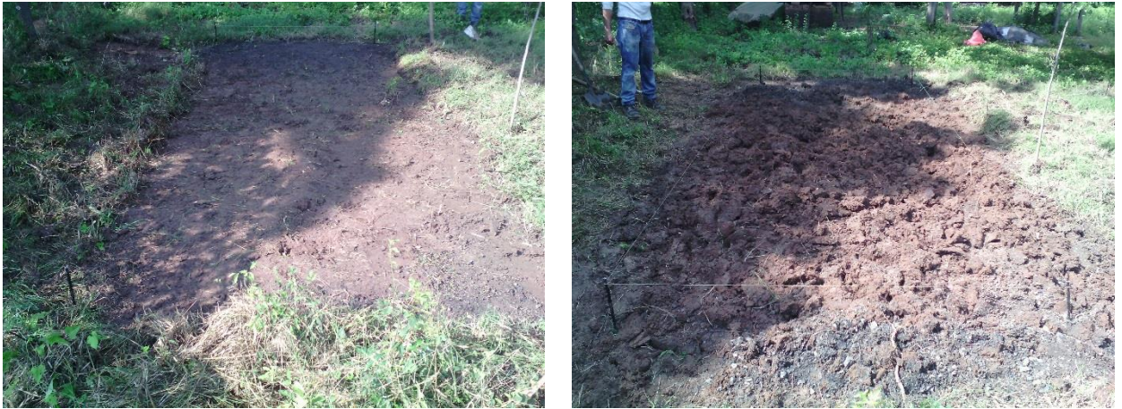
Imagen 5. Limpieza (izquierda) y escarbado del terreno (derecha).
