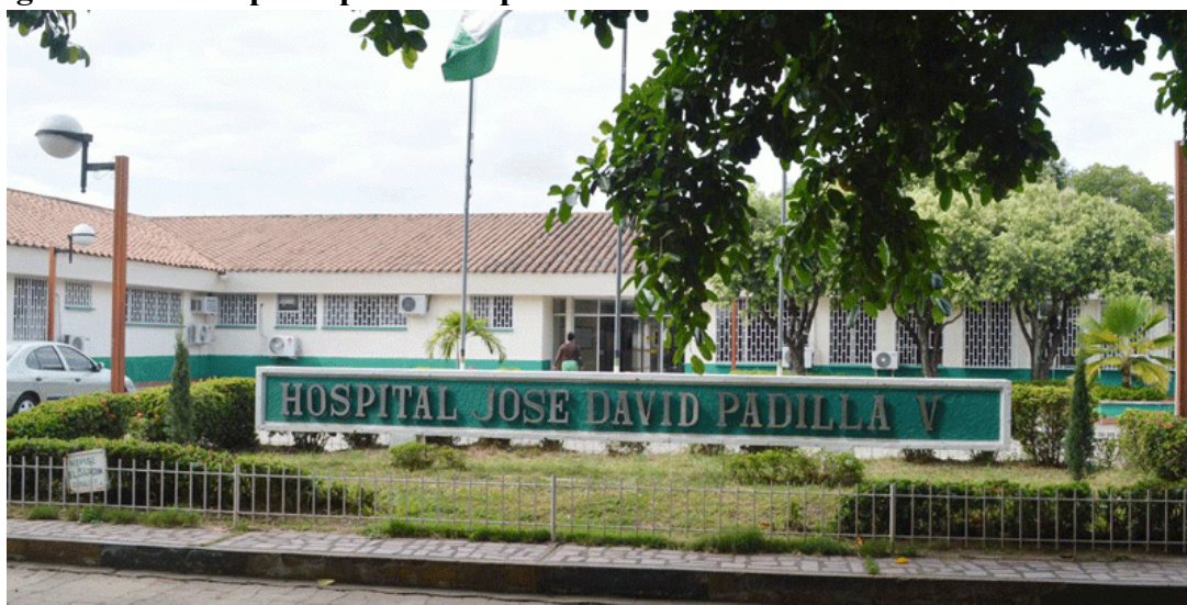
Imagen 2: Entrada principal del hospital
