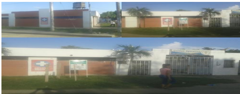
Imagen 4. Planta física de la E.S.E hospital local San Fernando sede Regidor Bolívar.
