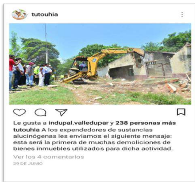
Imagen 6: Demolición de una casa en la Macarena
