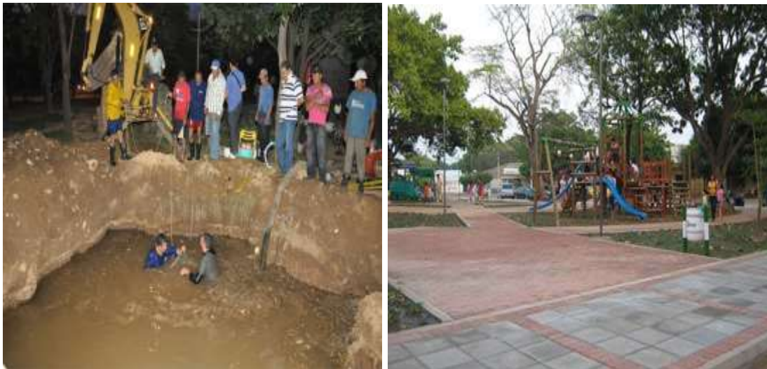
Anexo N°4: Descripción grafica de la mejora en la calidad y la cobertura de algunos servicios públicos básicos por parte de empresas como Emdupar (Izquierda) y reconstrucción de parques didácticos para recreación infantil (Derecha). Fuente: Las investigadoras
