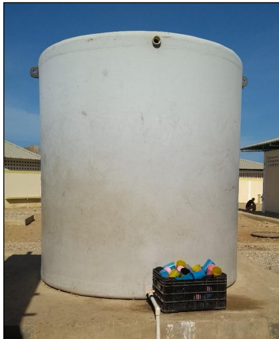
Fotografía 5 Tanque de almacenamiento prefabricado
