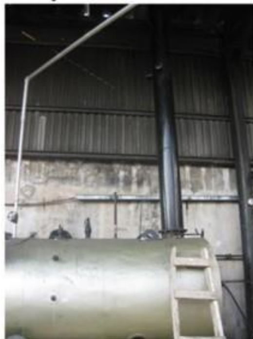
Figura 2 Aspectos de la chimenea de la caldera Distral
