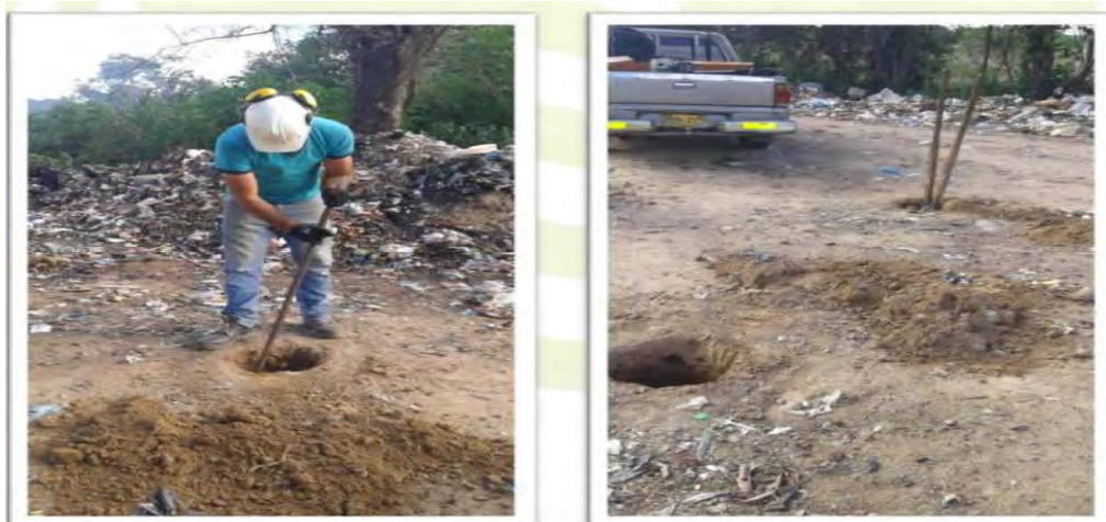
Imagen 13: Sondeo manual del estudio Geotécnico
