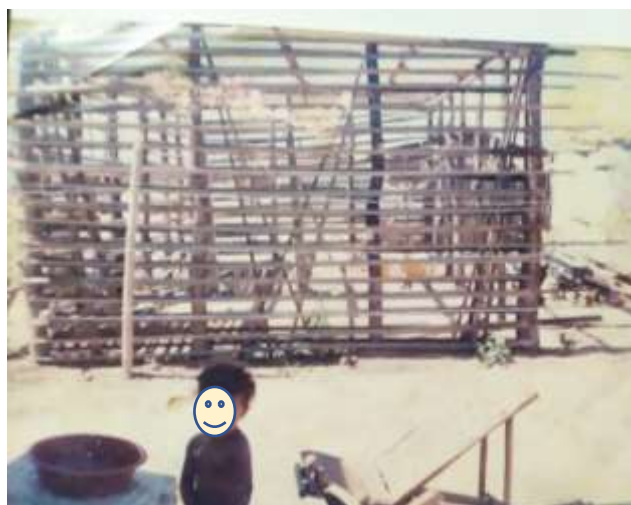
Fotografía SEQ Fotografía_ \* ROMAN VIII Casa de barro en construcción año 2000 de la Narradora 2
