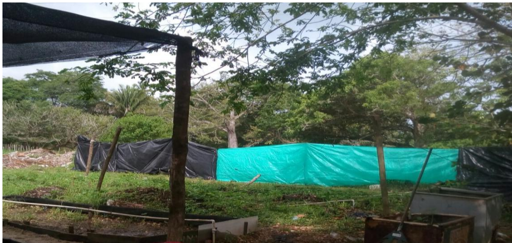
Fotografía 16. Encerramiento de la zona temporal de almacenamiento de residuos sólidos.
