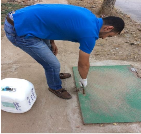
Imagen 1. Cubierta de la trampa de grasa
