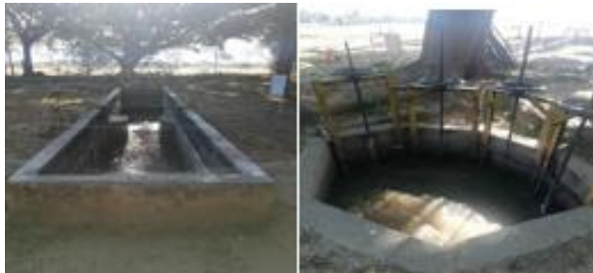
Foto 9. Canaleta Parshall y repartidor de caudal
