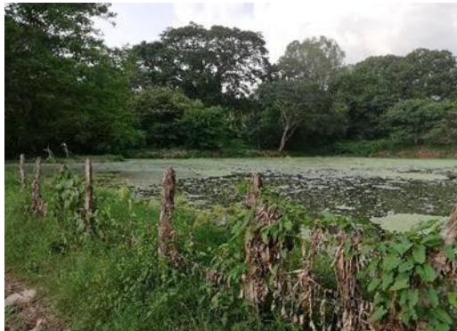
Foto 33. laguna anaerobica completamente colmatada y con vegetacion
