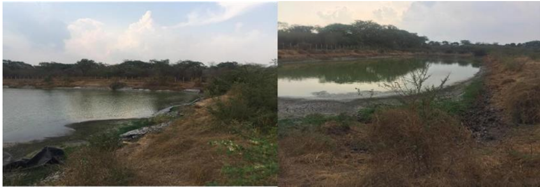
Foto 25. Lagunas de oxidación de La PAZ
