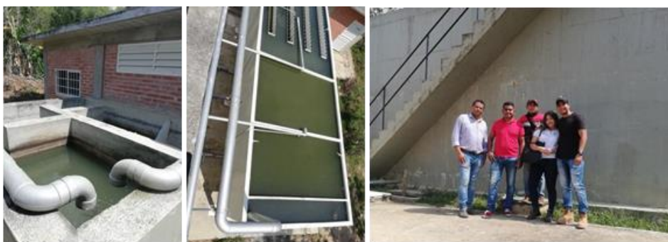
Foto 44. Operarios y tanque homogeneizador
