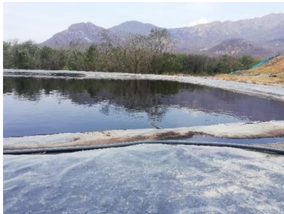
Foto 51. Piscina de lixiviados
