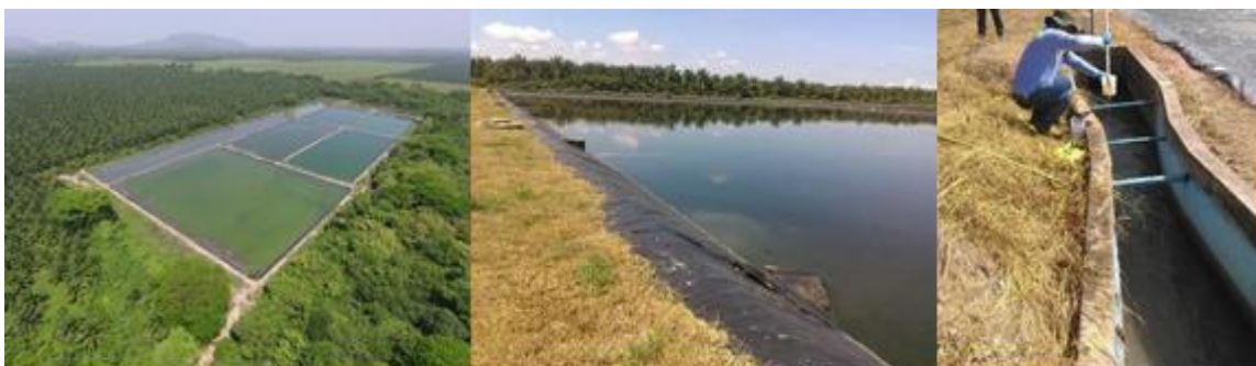
Foto 7. Sistema de tratamiento de aguas residuales Codazzi
