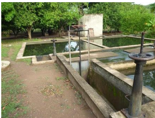
Foto 24. Pre-sedimentador
