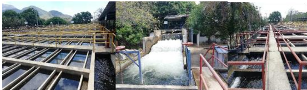
Foto 18. Sedimentadores y mezcla rápida
