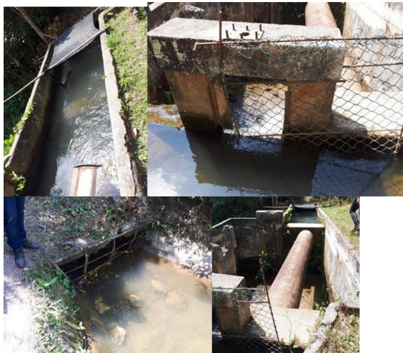
Foto 41. Captación, aducción, y desarenado
