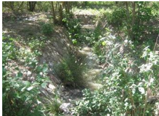
Foto 26. Estructura de llegada
