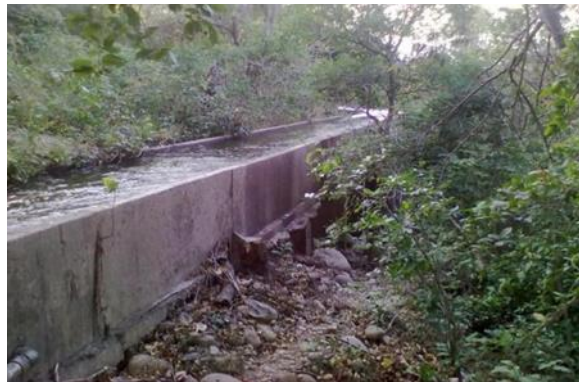
Foto 16. Canal de concreto armado de sección rectangular
