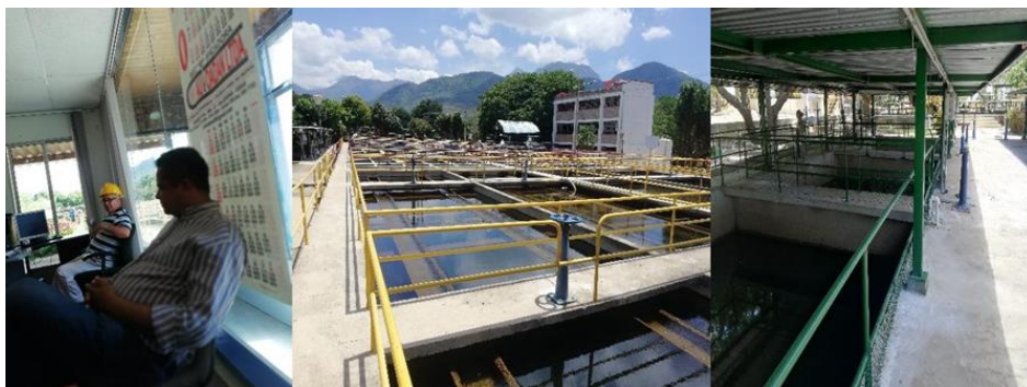
Foto 17. Oficinas de operación, floculadores y filtros del sistema
