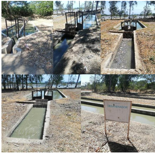
Foto 10. Desarenadores; modulos 1, 2, 3, 4.
