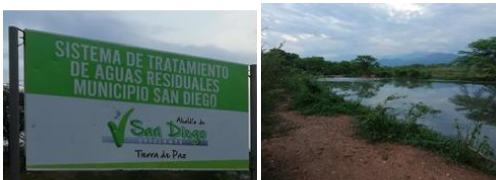
Foto 46. Sistema de tratamiento de aguas residuales
