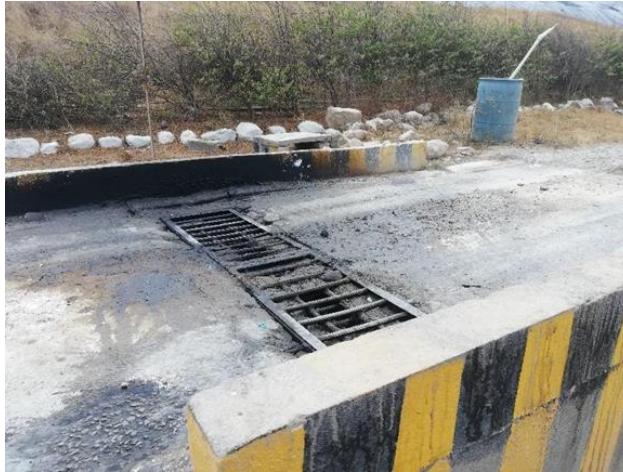
Foto 50. Estructura de desagüe de lixiviados
