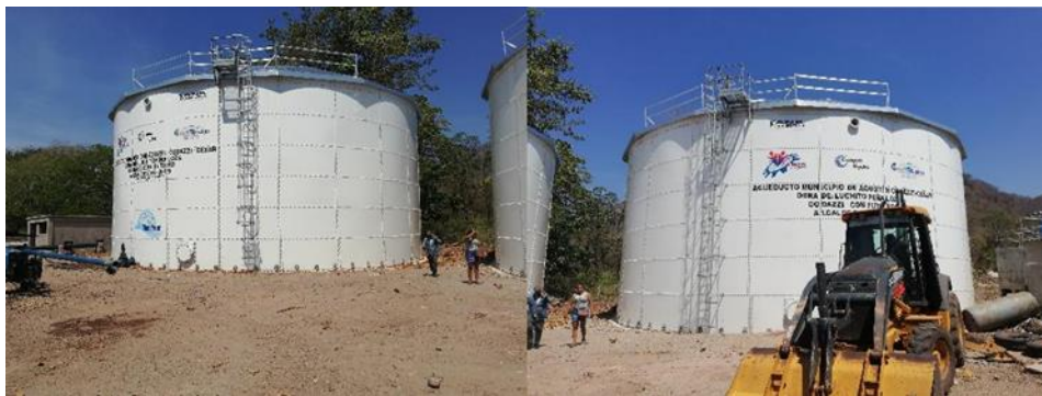
Foto 6. Tanques de almacenamiento 3000 m3
