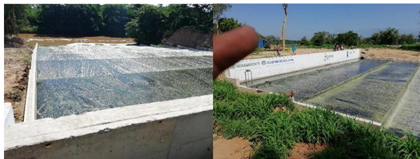
Foto 15. Planta de aireación
