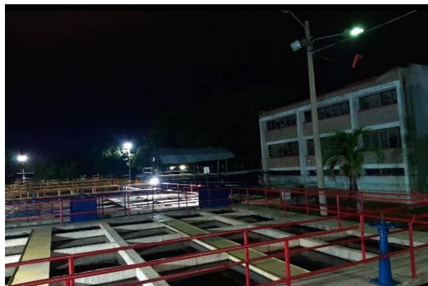
Figura 6. Planta de tratamiento de agua potable de Valledupar
