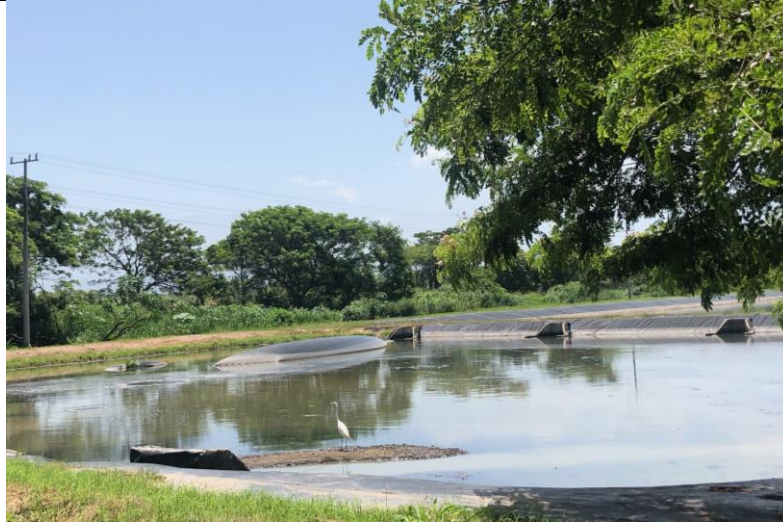
Figura 16. Lagunas Anaeróbicas, Facultativas y de Maduración (Fase II)
