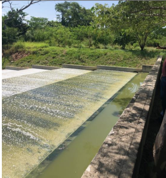
Figura 18. Vertimiento No.2: Zona de aireación
