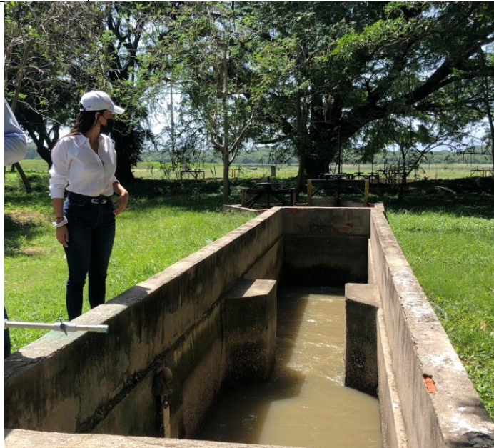
Figura 9. Medidor de Caudal
