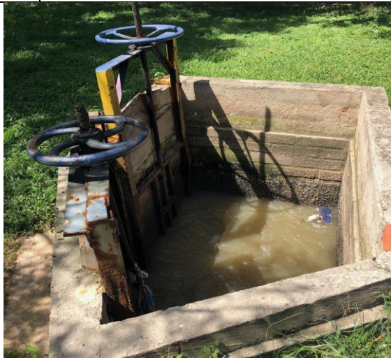
Figura 10. Cámara de Reparto
