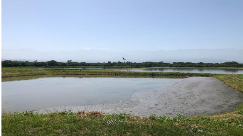
Figura 12. Laguna Anaeróbica (Fase I)
