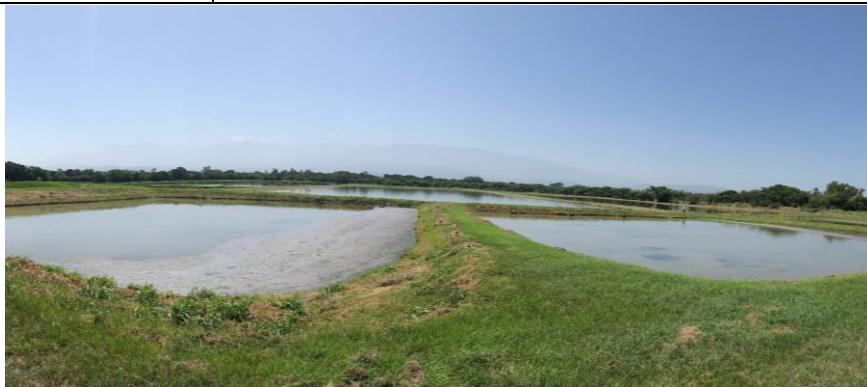
Figura 14. Laguna de Maduración (Fase I)
