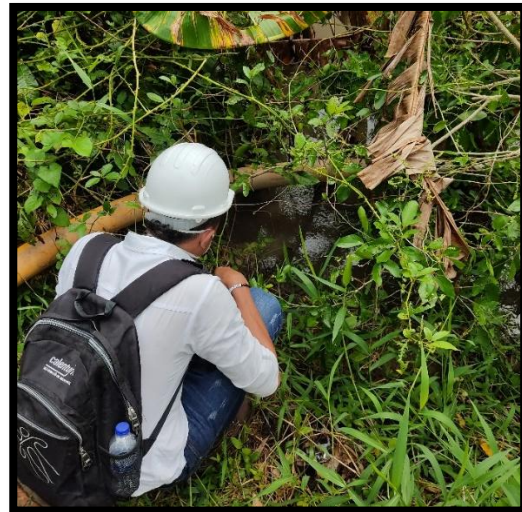
Tubería de Descarga Proveniente del Tanque de Almacenamiento
