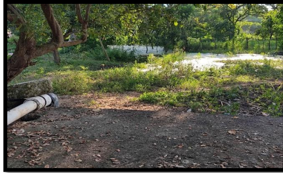
FIGURA 28 Charco de agua residual con agua lluvia
