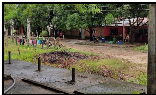
FIGURA 25 Habitantes viviendo a pocos metros del tanque de almacenamiento de aguas residuales
