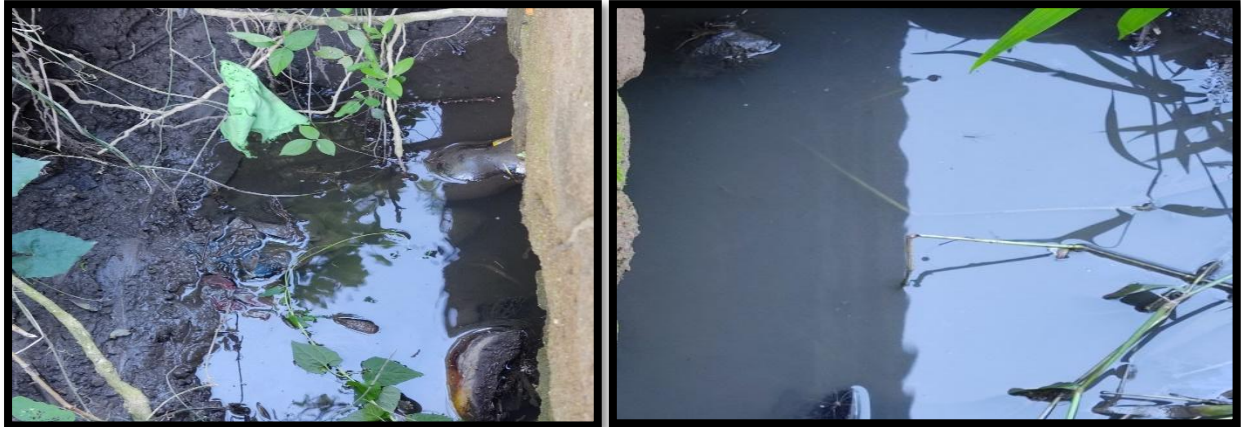
FIGURA 34 Aguas grises estancadas en lugares bajos en la zona de vertimiento.
