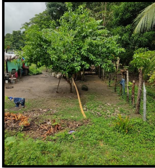
Tubería de Descarga Proveniente del Tanque de Almacenamiento
