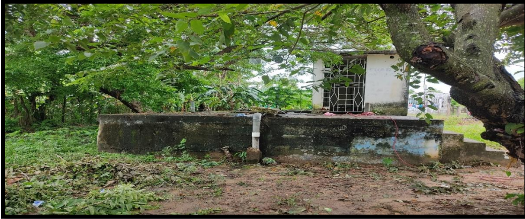
FIGURA 8 Tanque de Almacenamiento Aguas Servidas
