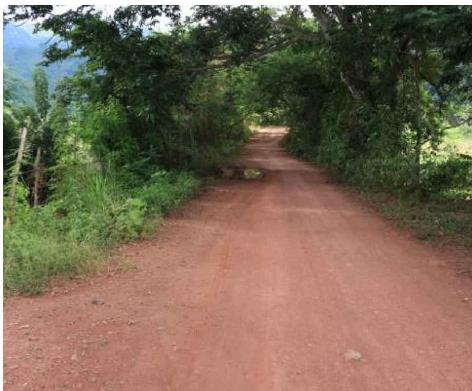
Figura 7. Imagen del estado actual de la infraestructura vial de la vereda
