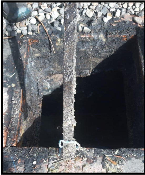
Figura 4 y 5. Evidencia de residuos sólidos en trampa de grasa.
