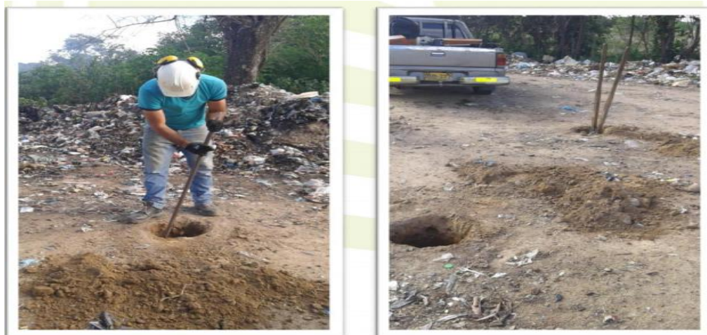
Imagen 16 Sondeo manual del estudio Geotécnico
