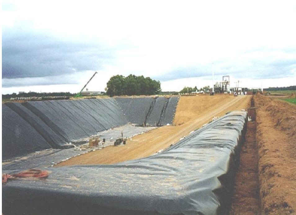
Imagen 19 Método de trinchera o zanja
