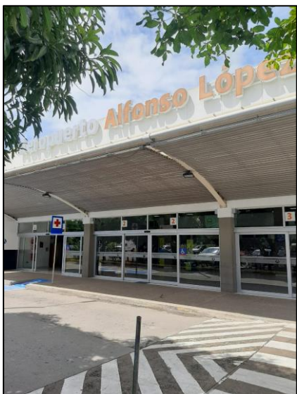
Ilustración 12. puertas de entrada del terminal
