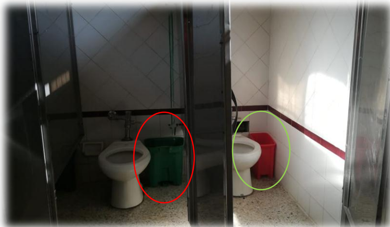
Imagen 9. Sanitarios con recipiente adecuado y no adecuado para RESPEL en la Unicesar sede Sabanas.
