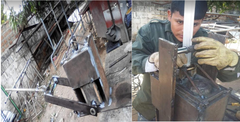
Ilustración 17. Construcción de la máquina. Fuente: Autores, 2021.
