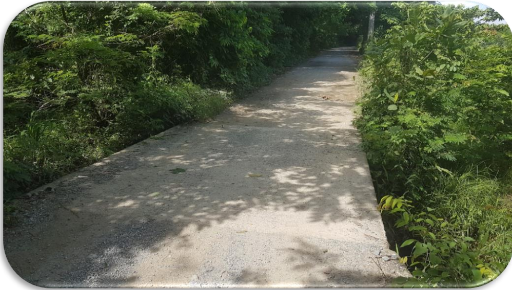
Obra Hidráulica Existente (Alcantarilla)
