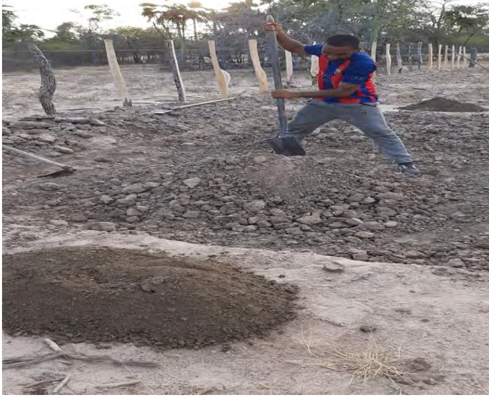
Figura 29: Adecuación del área de estudio.
