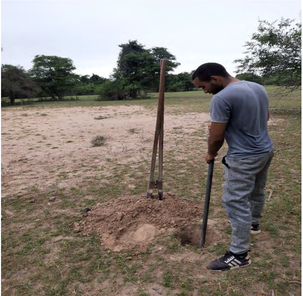
Figura 26: Adecuación del área de estudio.
