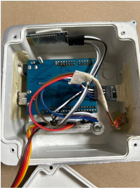
Figura 13. Montaje soldado y conectado.
