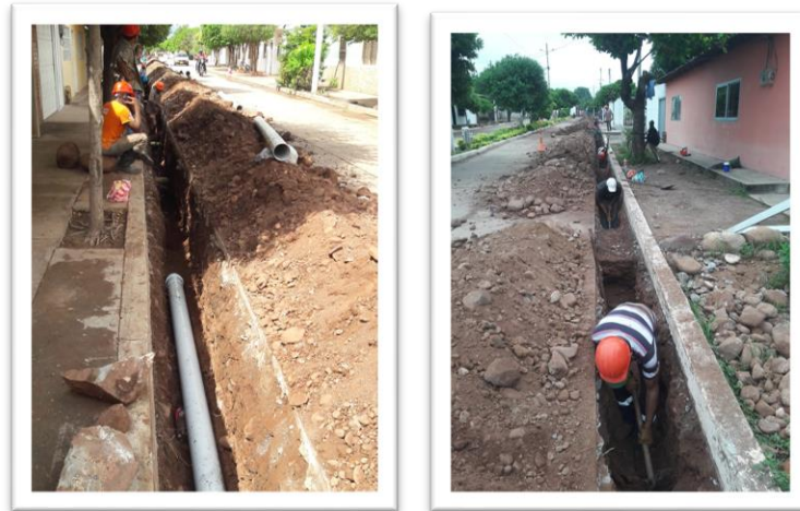
Ilustración 19 y 20 Instalación tubería Madre Fuente: (Autores,2020)
