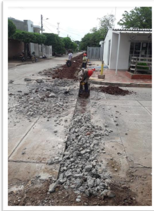
Ilustración 12 Demolición para instalación de redes de distribución Fuente: (Autores,2020)
