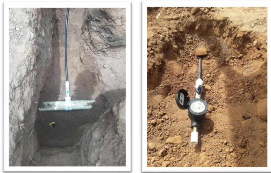
Ilustración 26 y 27 Instalación de accesorios Fuente: (Autores,2020)
