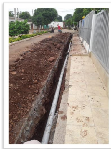
Ilustración 21 Instalación tubería madre Fuente: (Autores,2020)
