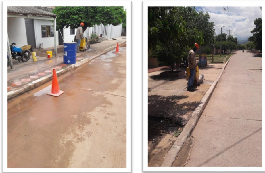
Ilustración 10 y 11 Corte de Pavimentos Fuente: (Autores,2020)
