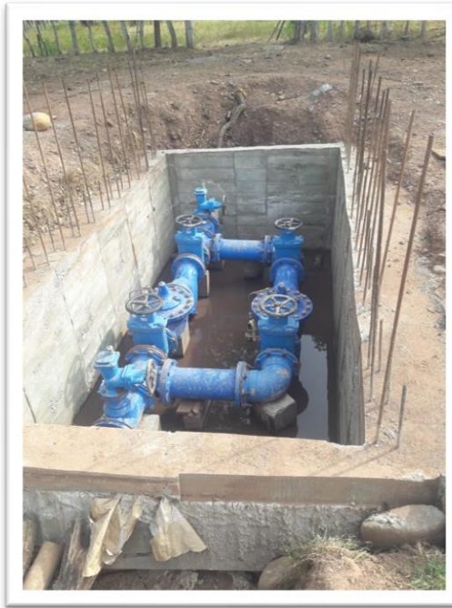
Ilustración 46 y 47 Estación Reguladora de presión Fuente: (Autores,2020)
