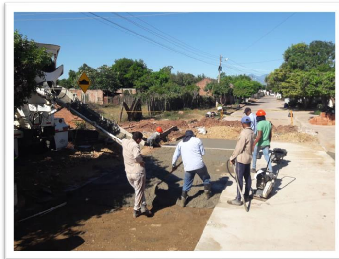
Ilustración 44 Pavimentación Fuente: (Autores,2020)
