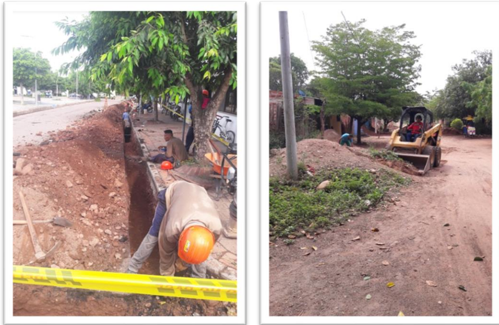
Ilustración 15 y 16 Excavaciones Fuente: (Autores,2020)
