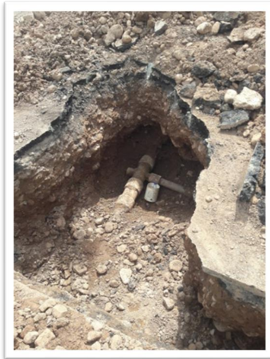
Ilustración 30 Instalaciones de codos y uniones Fuente: (Autores,2020)
