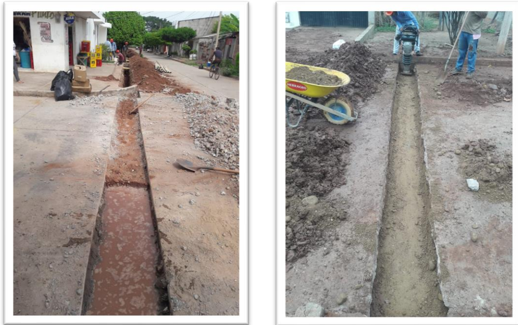
Ilustración 35 y 36 Adecuación del terreno Fuente: (Autores,2020)
