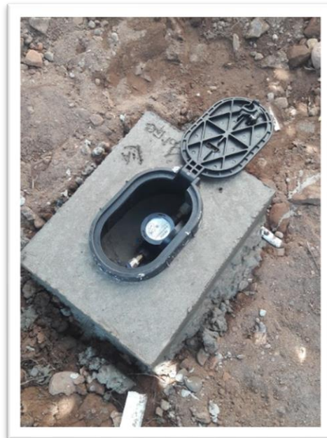
Ilustración 32 Medidor Fuente: (Autores,2020)
