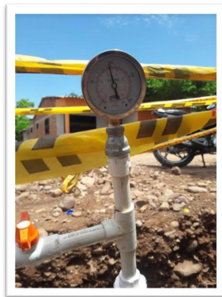
Ilustración 33 y 34 Pruebas de presión
