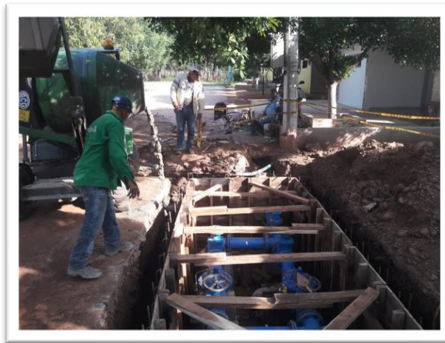
Ilustración 45 Construcción de estación reguladora de presión Fuente: (Autores,2020)
