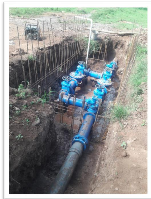
Ilustración 46 y 47 Estación Reguladora de presión Fuente: (Autores,2020)
