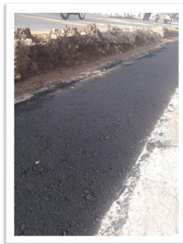
Ilustración 41 Asfalto Fuente: (Autores,2020)
