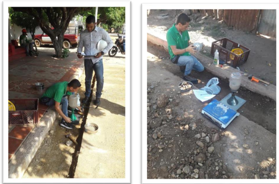
Ilustración 37 y 38 Densidad del terreno Fuente: (Autores,2020)
