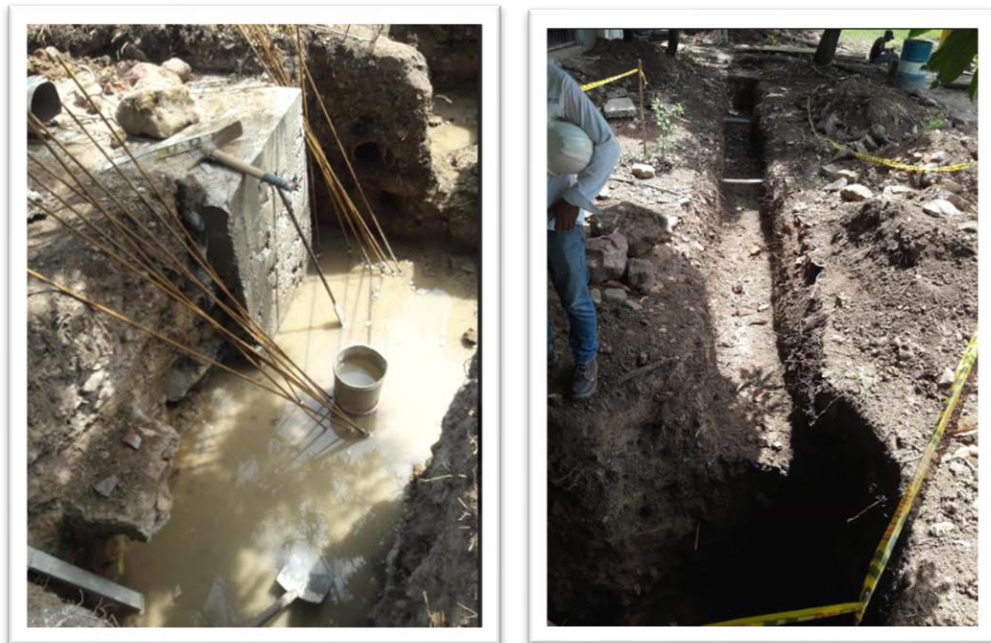
Ilustración 51 y 52 Adecuaciones en la PTAP Fuente: (Autores,2020)
