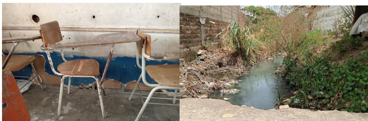
Figura 4. Condiciones de infraestructura interna y externa de la sub sede del colegio san Joaquín sub sede paraíso
