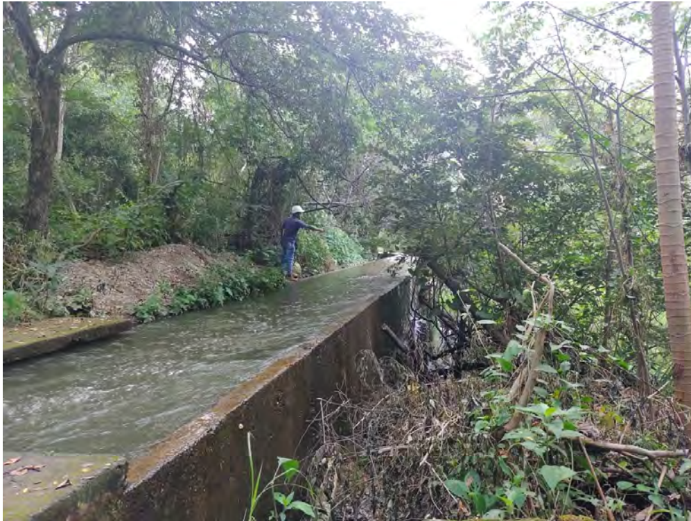
Canal de aducción
