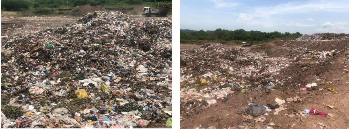
Figura 10. disposición de los residuos sólidos fuera de la celda de operación
