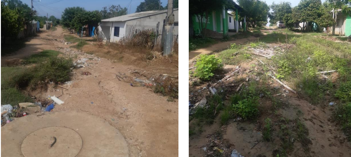
Figura 7. Vías en mal estado
