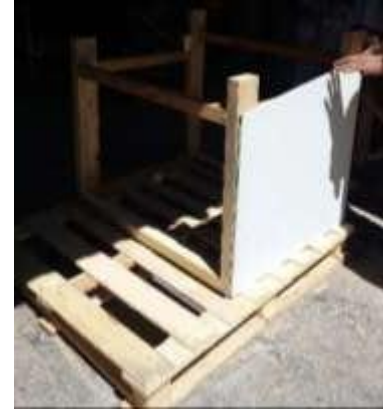
Instalación de paredes
