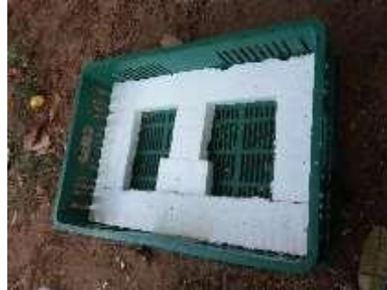
Aligerante para reducción de espesor
