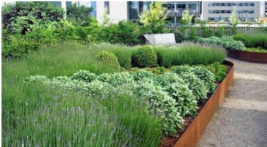
Figura 2. Cubierta verde semi-intensiva.
