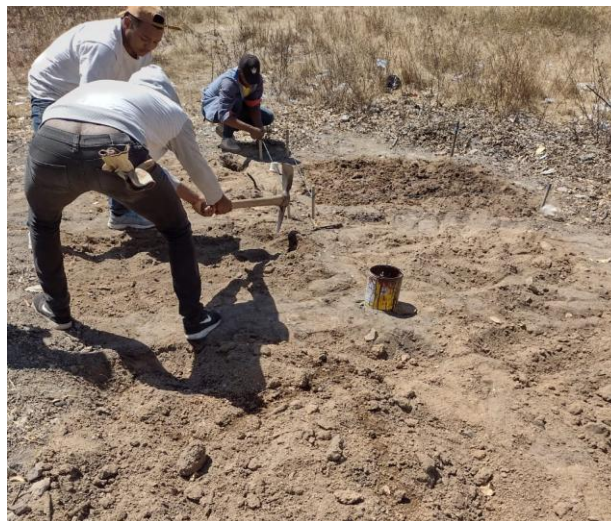
Figura 12 Selección y limpieza del sitio para el montaje piloto
