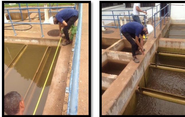
Ilustración 10 Sedimentadores PTAP 1 Fuente: (Autores,2020)
