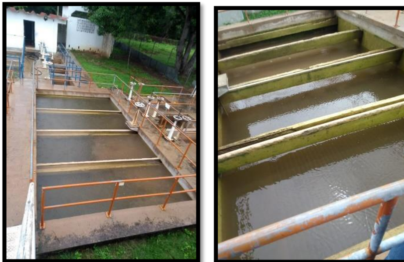
Ilustración 13 Sedimentador PTAP 2
