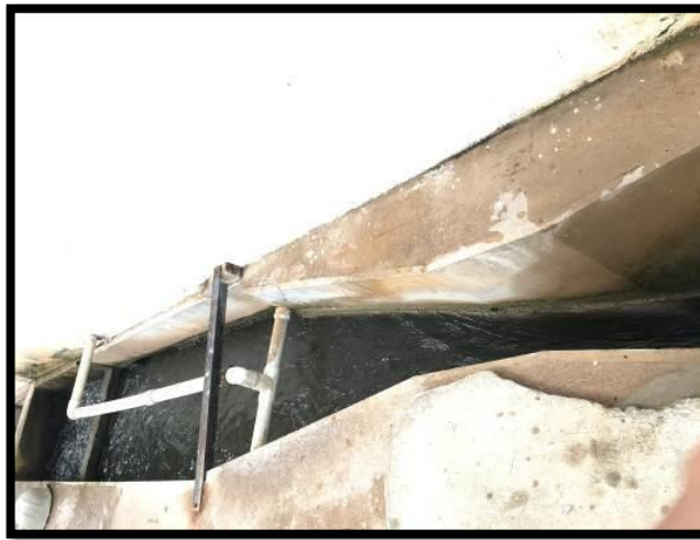
Ilustración 6 Canaleta Parshall
