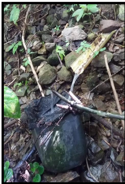
Figura 13. Captación 1. Fuente: Autores, 2020.
