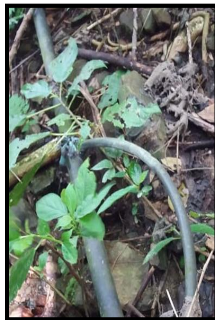
Figura 14. Conexión al tubo madre. Fuente: Autores, 2020.
