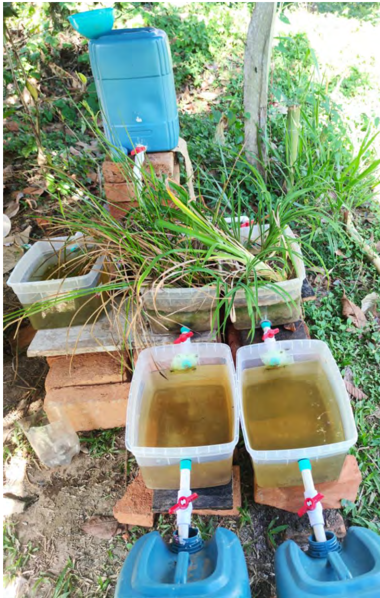
Figura 19 Montaje del humedal artificial de flujo subsuperficial.
