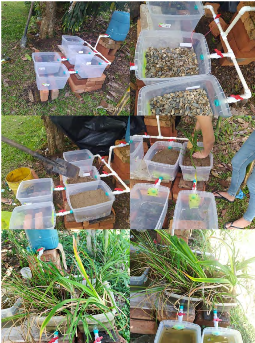
Figura 18 Construcción del humedal Artificial
