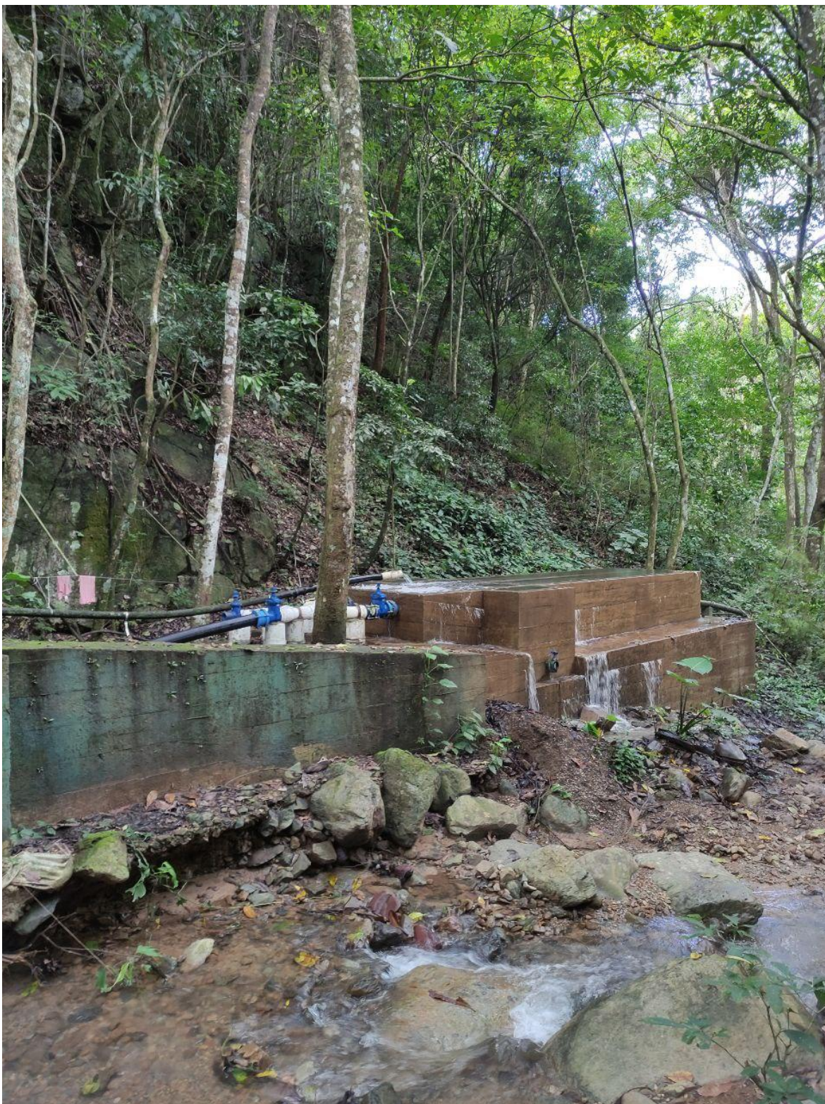
Desarenador ubicado en quebrada la esperanza registro fotográfico.
