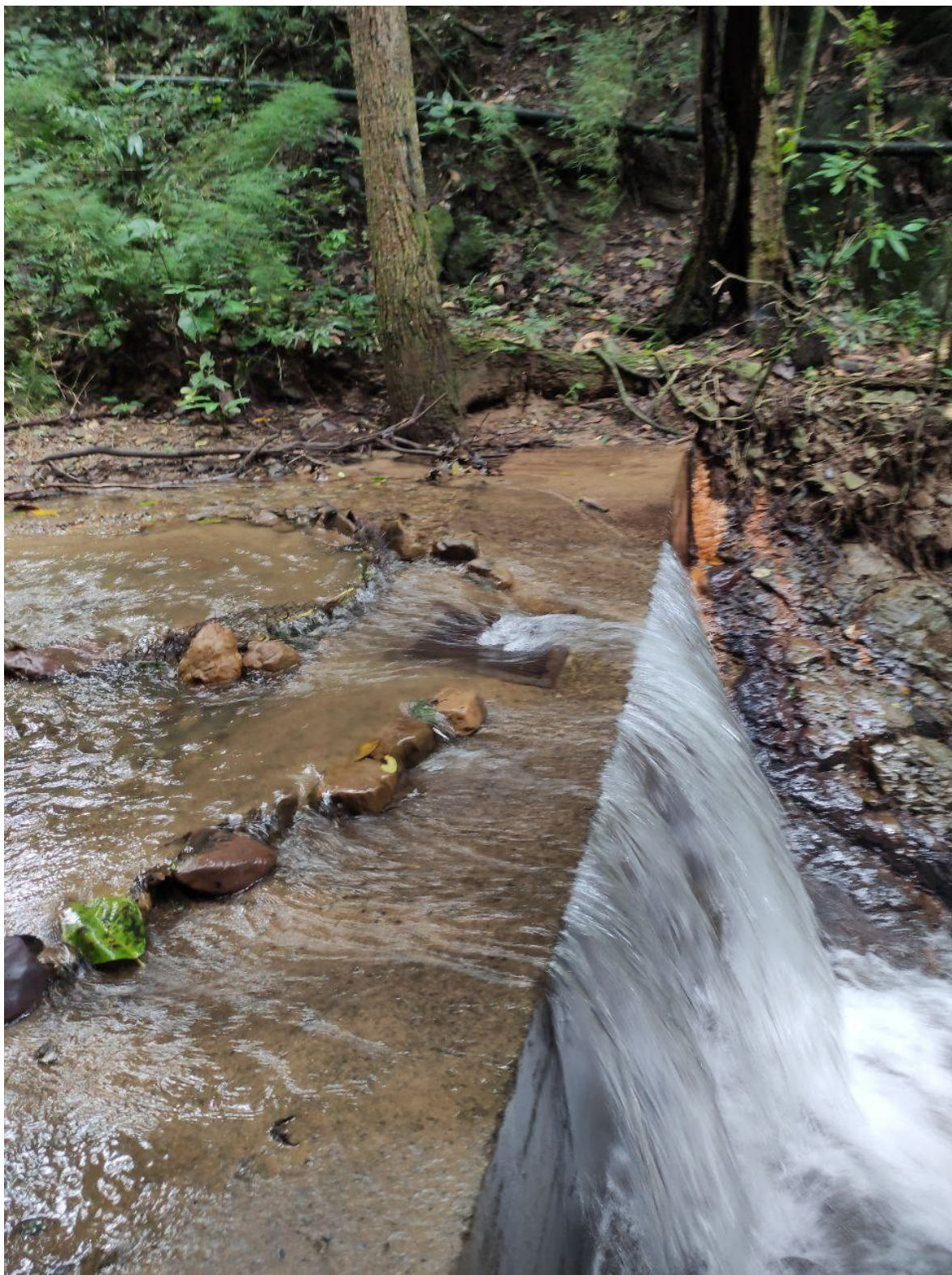
Captación quebrada la esperanza registro fotográfico
