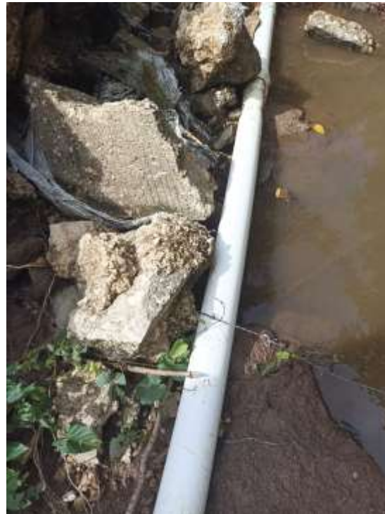
Figura 16 Tubería de conducción
