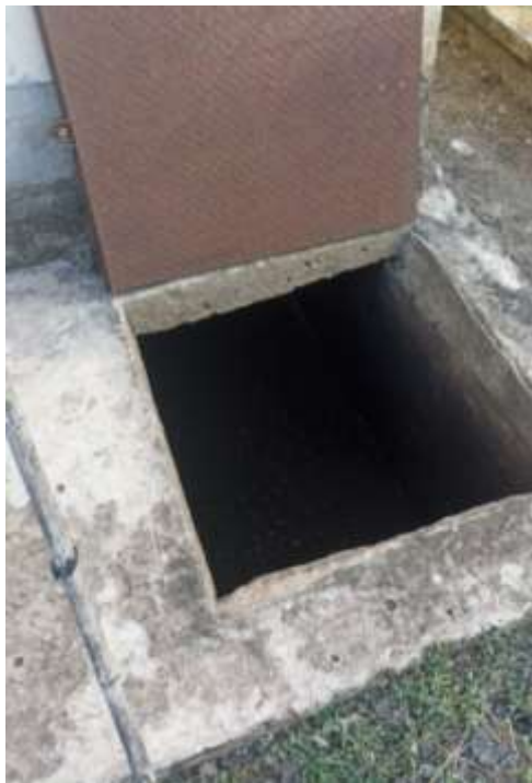
Figura 14 Tanque succión
