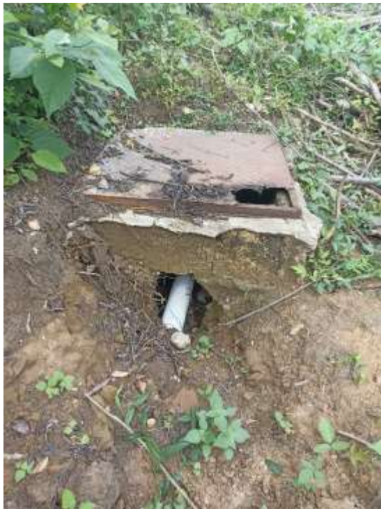
Figura 17 cámara de inspección
