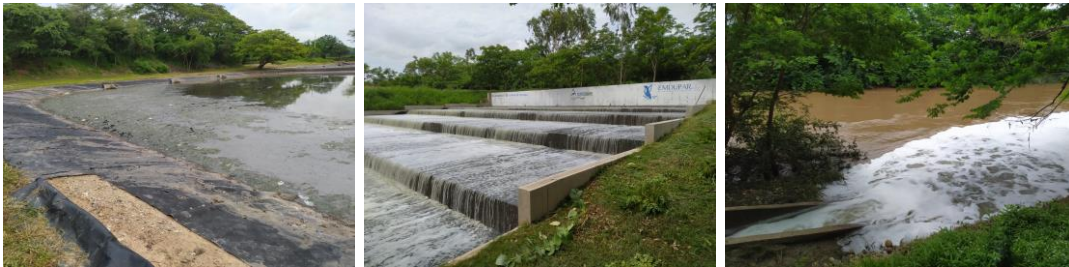
Figura 7. Planta de Tratamiento de Aguas residuales (PTAR)
