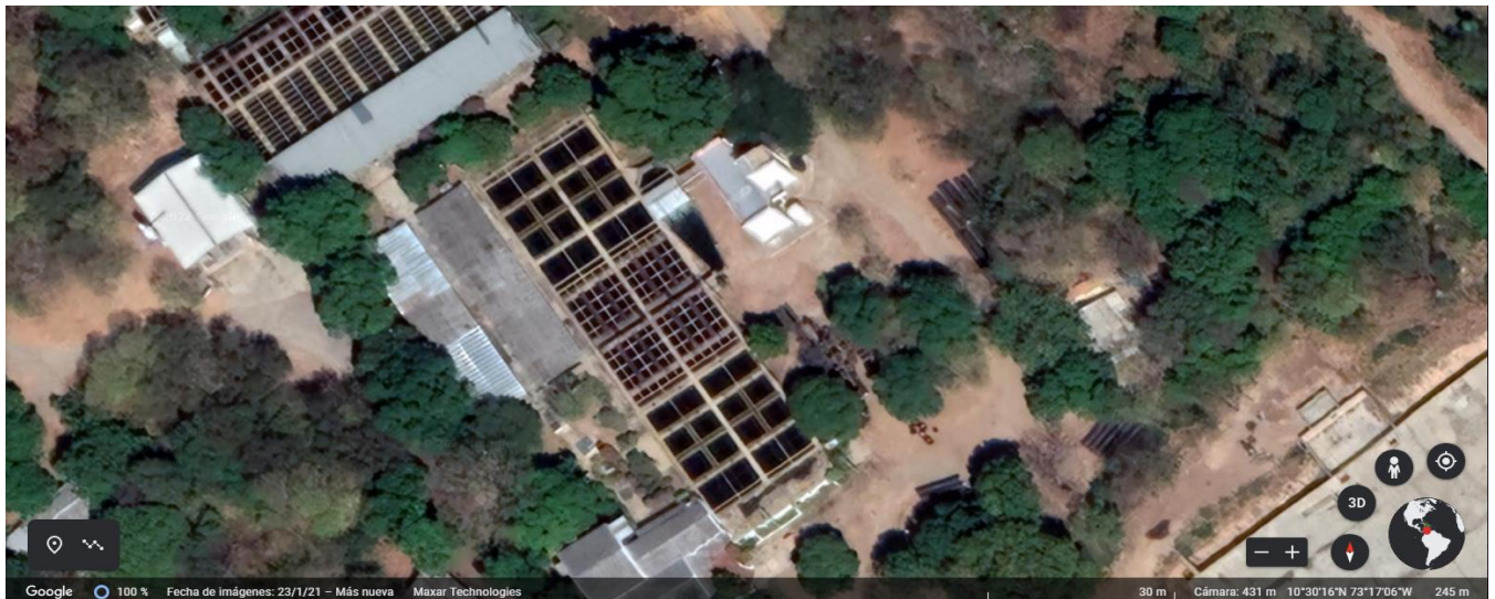
Figura 5. Localización de la Planta de Tratamiento de Emdupar.
