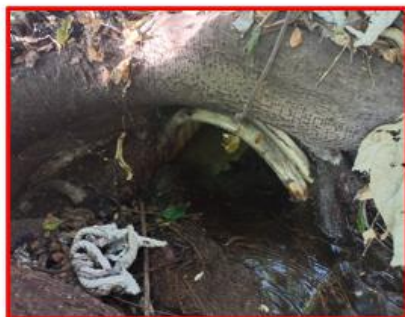
Afluente subterráneo de la Laguna No 3.
