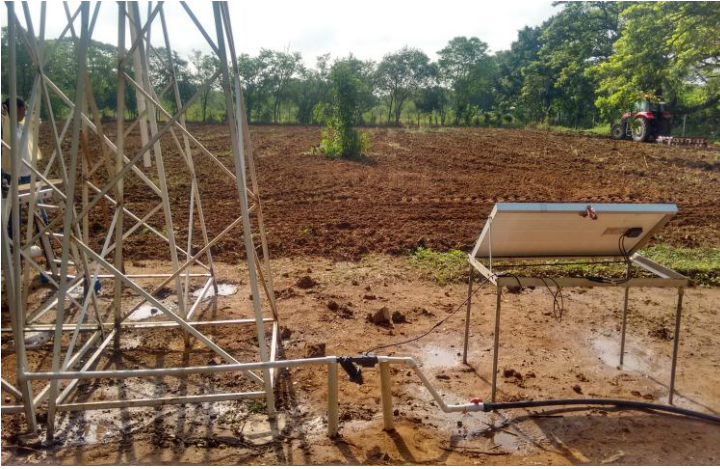
Adecuación del terreno
