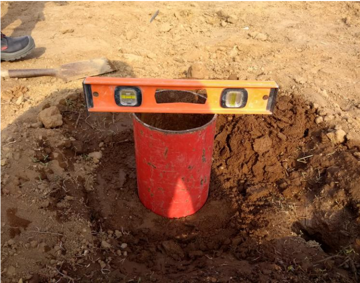
Prueba de Infiltracion
