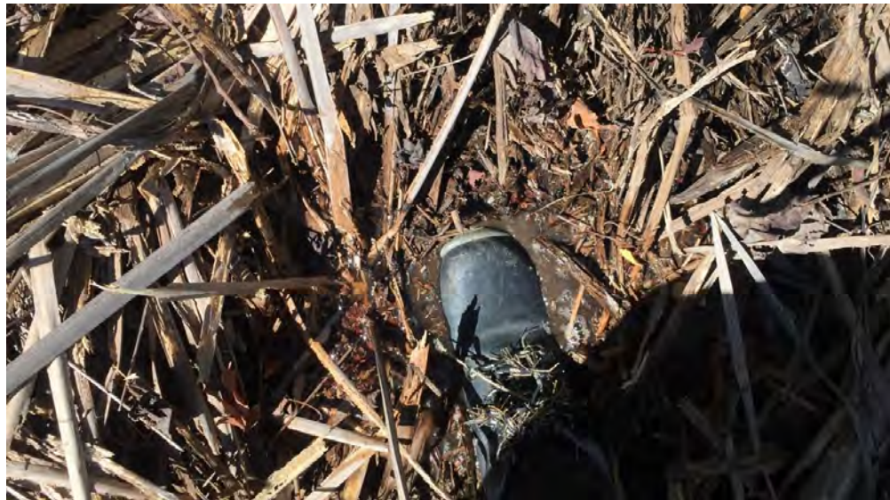
Figura 42. Filtración de agua en el suelo, generada hipotéticamente por el tanque de almacenamiento de agua potable en la parcela P-333
