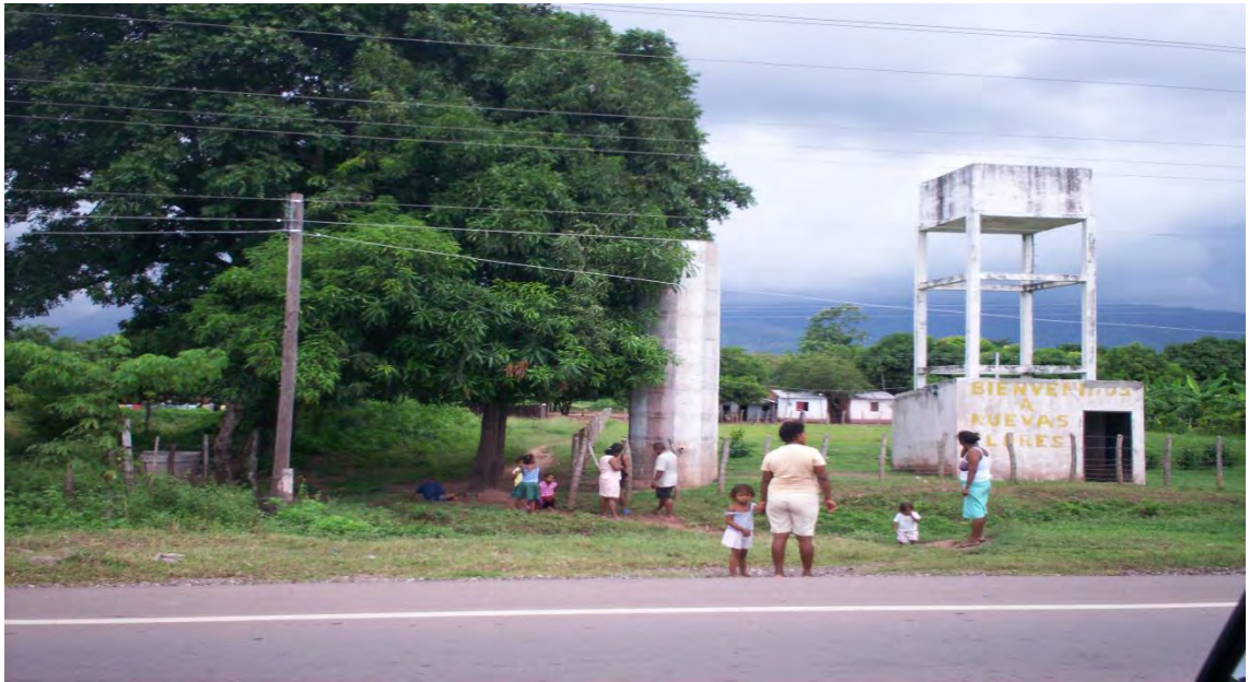
VISTA CASETA DE ALJIBE Y TANQUE ELEVADO DEL ACUEDUCTO
