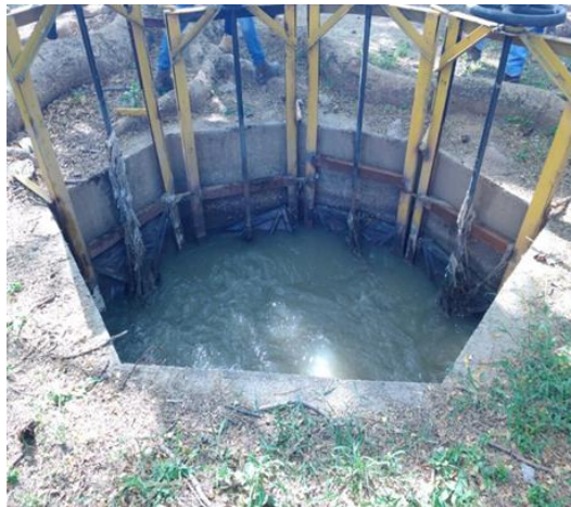
Ilustración 2: Cámara de reparto Fuente: Autores, 2018.
