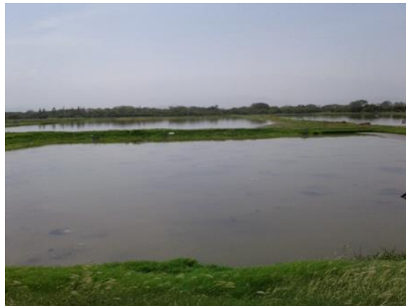
Ilustración 4: Lagunas anaerobias Fuente: Autores, 2018.
