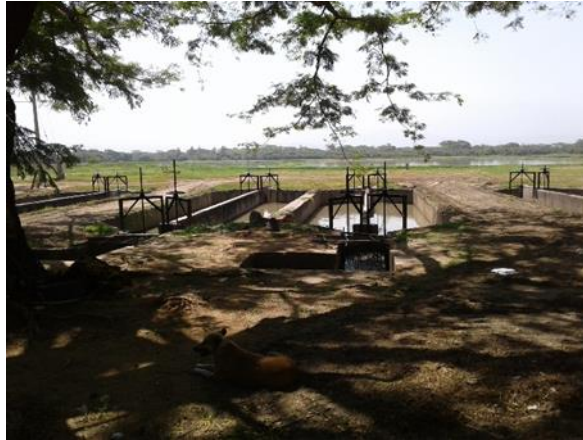
Ilustración 3: Cribado y desarenador Fuente: Autores, 2018.
