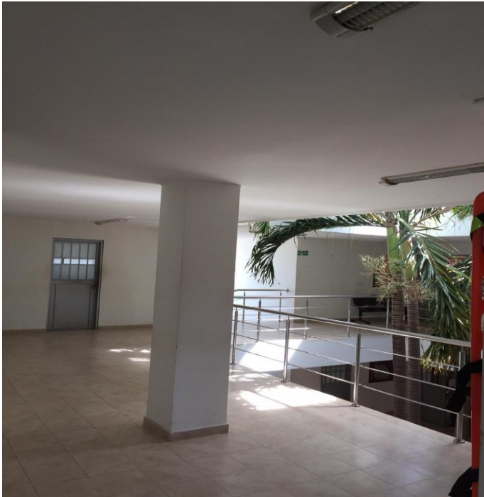
Pasillos del segundo piso.
