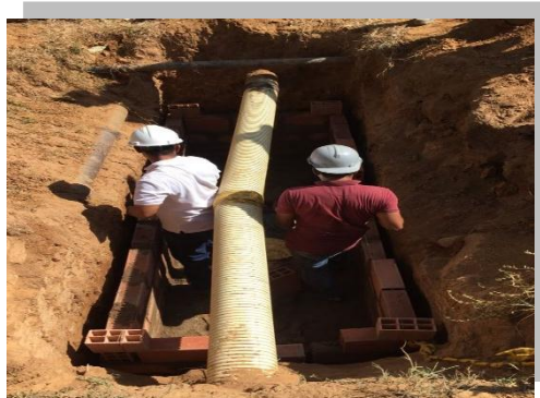
Figura 7. Construcción del humedal.
