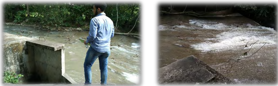
Imagen 7. Bocatoma y Estructura de Captación Lateral
