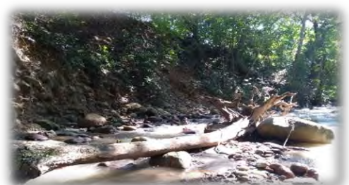
Imagen 15. Erosión y desplome lateral
