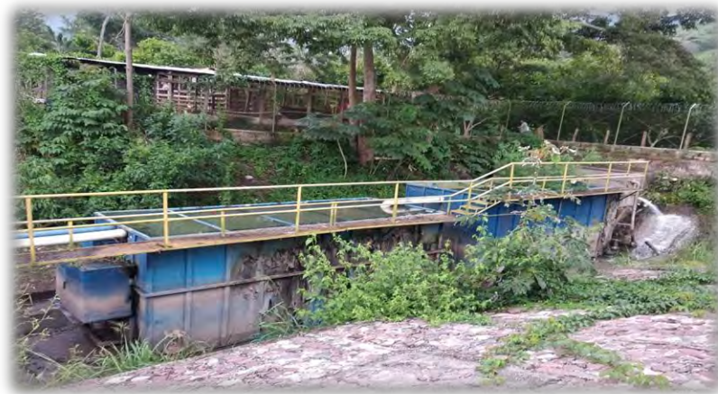
Imagen 19. PTAR San José de Oriente
