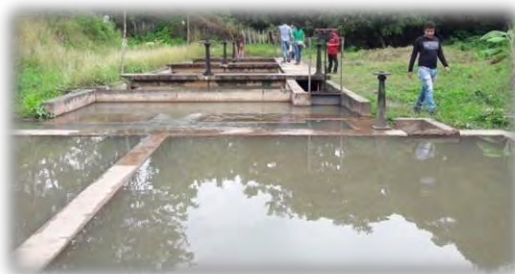
Imagen 9. Presedimentador
